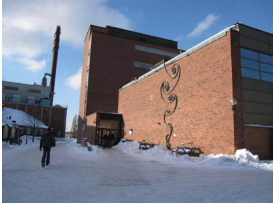
Linne Flow Centre の建物
