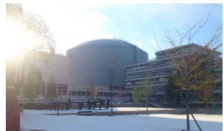
CEA 施設内にある原子炉
