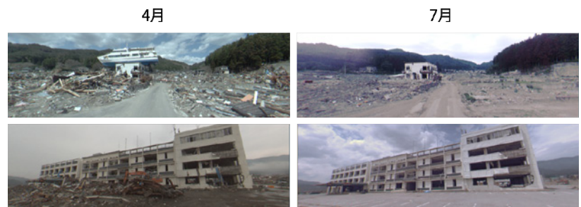
Fig.4 津波被害の記録画像
