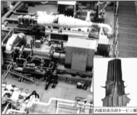
ガスタービン・圧縮機試験設備
