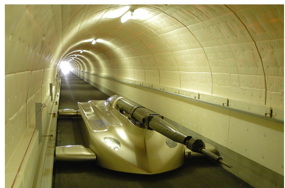
新たに設置された曳航風洞
