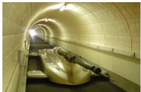
新たに設置された曳航風洞
