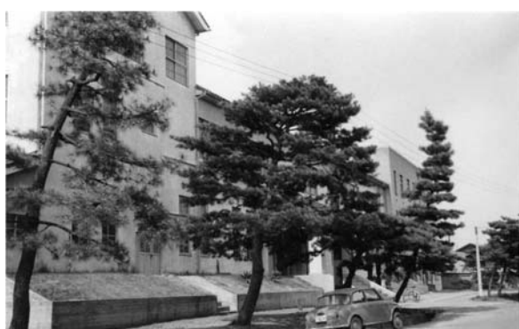
写真 1. 1970 年頃の速研 1 号館
