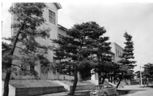
写真 1. 1970 年頃の速研 1 号館
