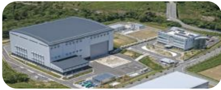
櫛葉遠隔技術開発センター(櫛葉町)
